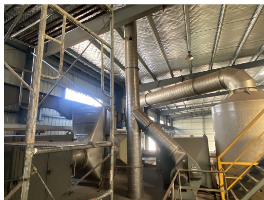
1#生产线流平烘干加热炉废气汇通流平烘干 废气一并进低温等离子+活性炭吸附后 15m 高排气筒（G5-2）排放
