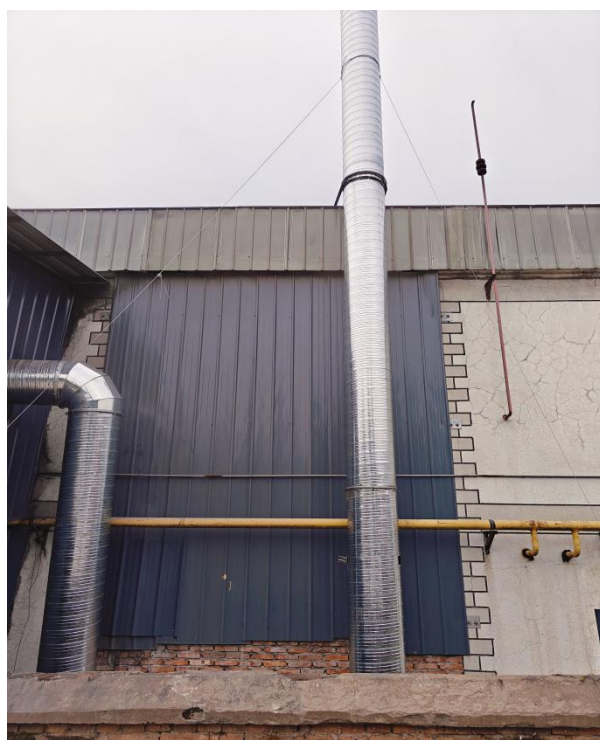
再生砂废气处理设施排气筒（DA001）
