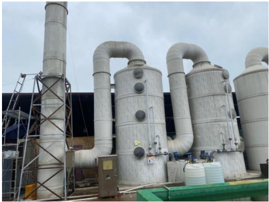
酸洗、电解抛光废气处理设施（在用）
