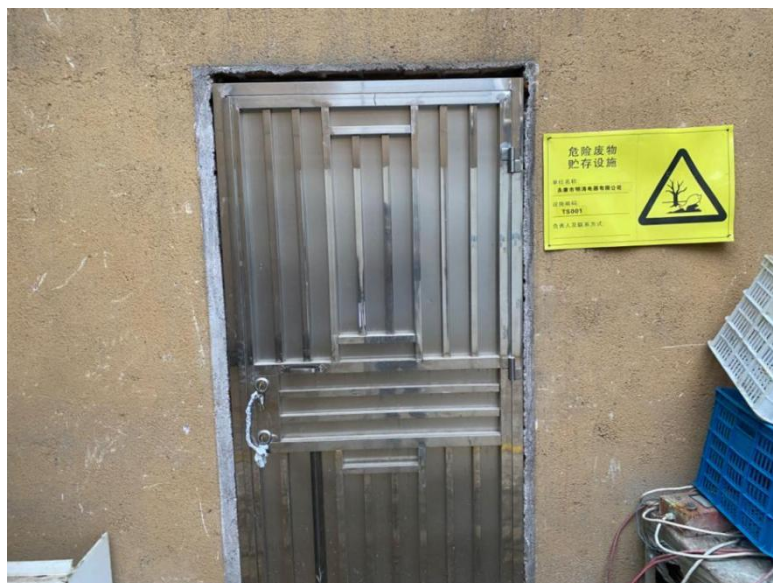
图 4.1.4-1 危废仓库外部
