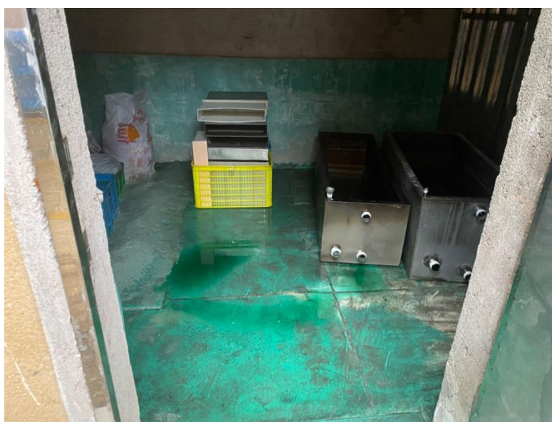
图 4.1.4-2 危废仓库内部
